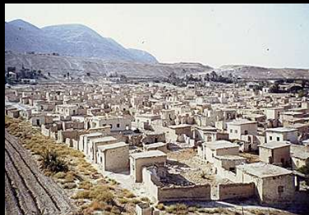
Die evakuierten Kolonisten leben in eilig errichteten Baracken
